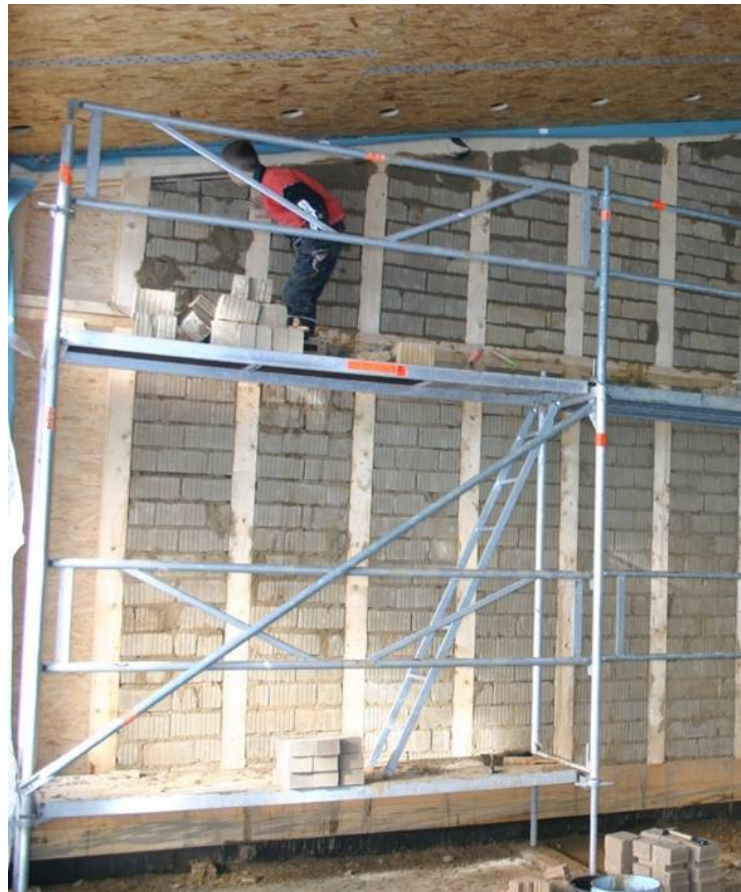
Obr.4 Vyzdívka vnitřních stěn cihlami z nepálené hlíny
